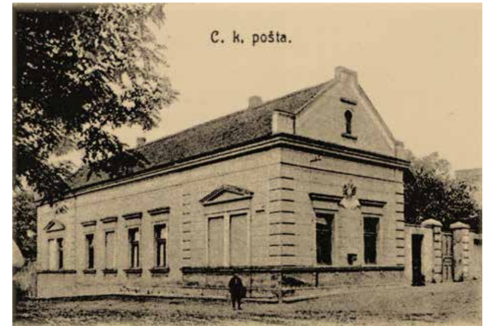
Dům č. p. 2, kde od r. 1904 fungoval poštovní úřad Čakovice, archiv kroniky MČ Praha-Čakovice
