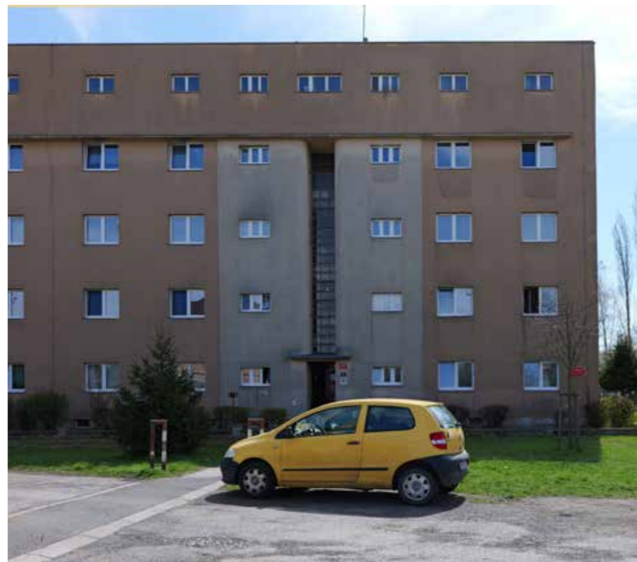
Foto: Michaela Šimůnková, bytový dům U Nádraží po výměně oken
