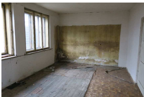
Obývací pokoj domu č.p. 141
