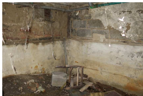
Sklep dvojdomu č.p. 140 a 141
