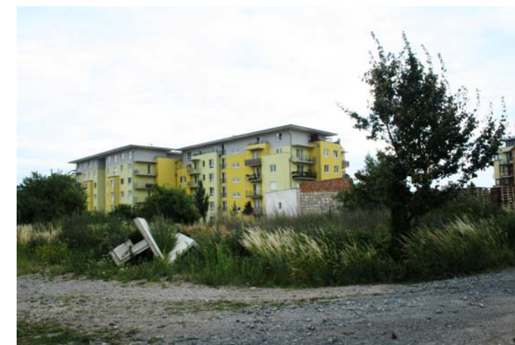
04 příchod z ulice Tryskovičká do areálu sídliště
