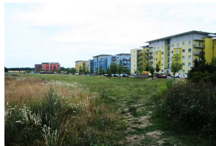
11 přechod z ulice Tryskovičká do parku
