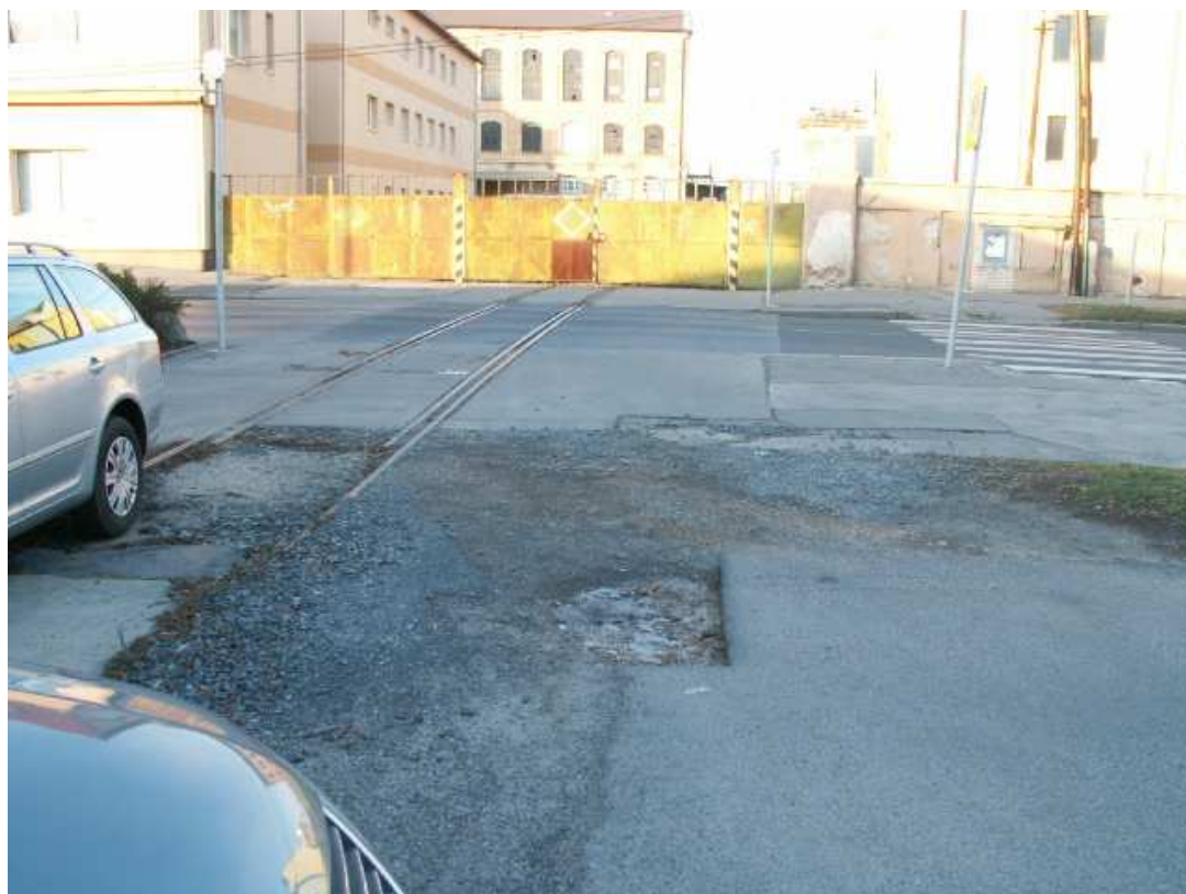
Vlečka před vjezdem do areálu bývalého cukrovaru
