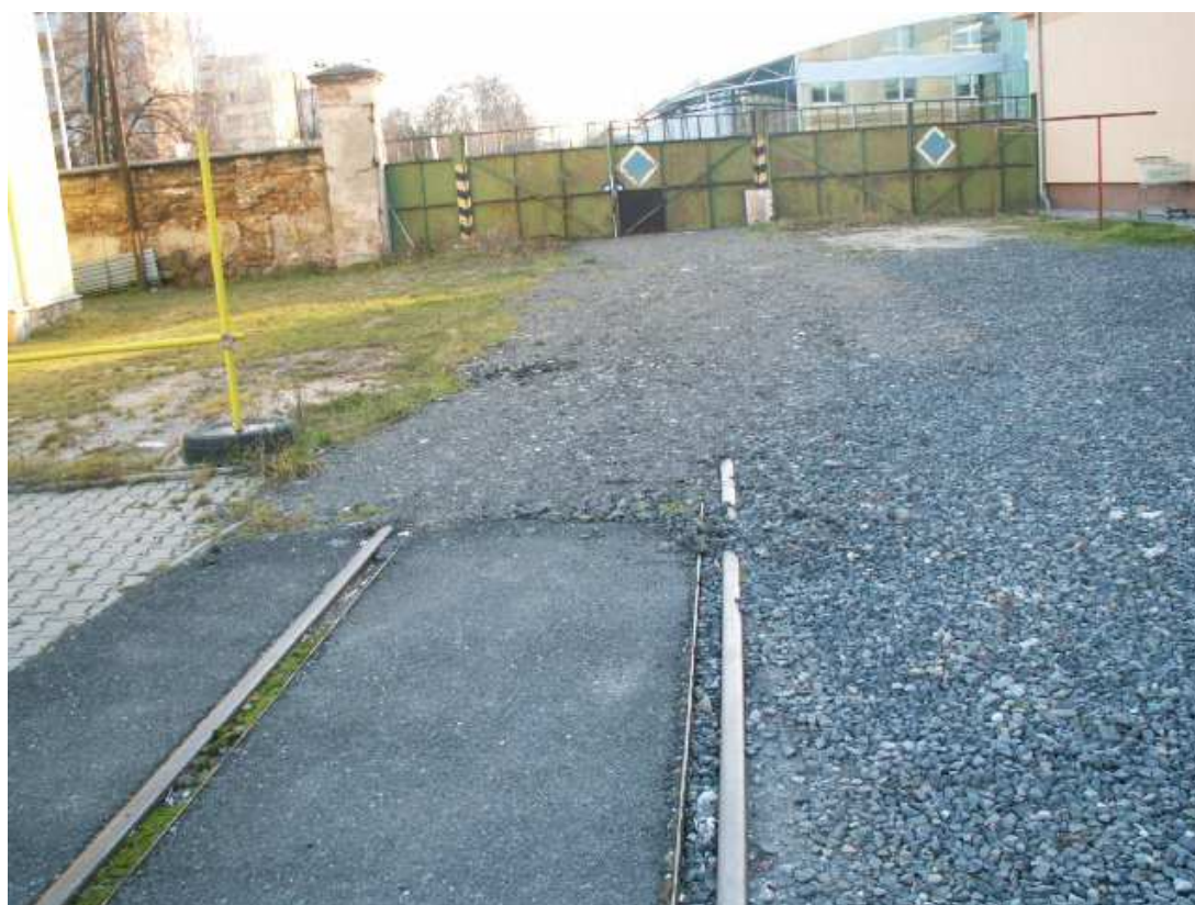
Vlečka za vjezdem do areálu bývalého cukrovaru
