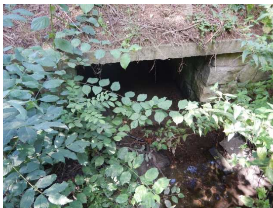
Výtok ze zatrubněného úseku intravilánu
