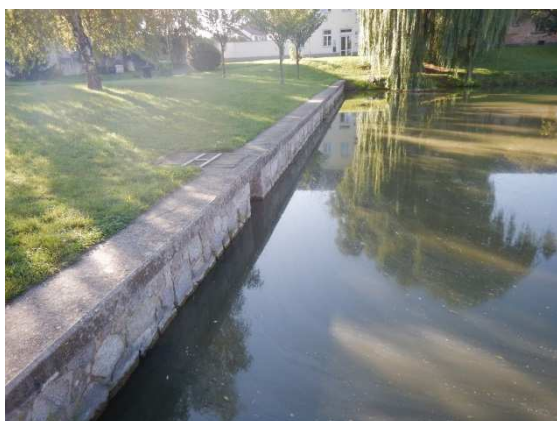
SV kratší stěna s vypouštěcím objektem
