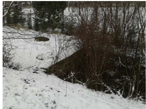
Vtok do zatrubnění nad Tryskovickou ulicí
