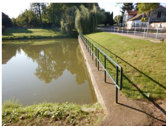
VZ kratší stěna se zábradlím podél silnice
