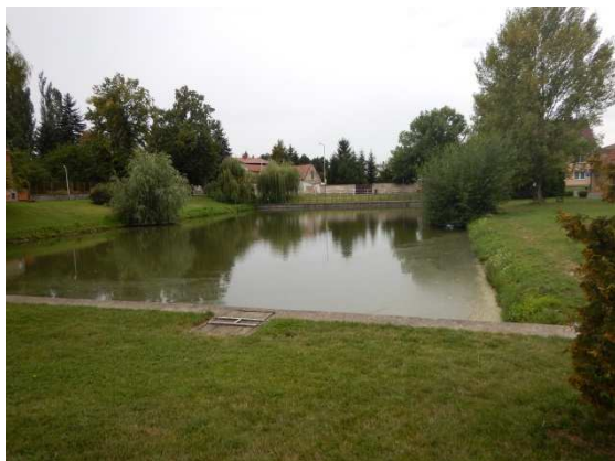
Celkový pohled na nádrž od SV
